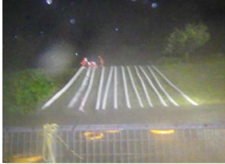
丸森町ポンプ車排水作業
