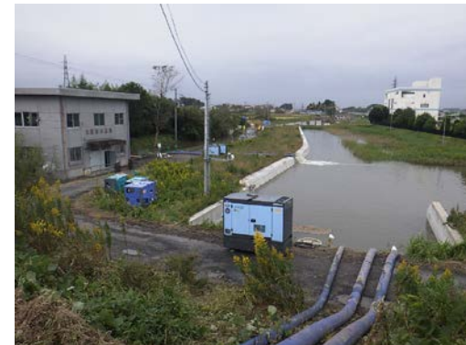
迫町揚水機場排水作業 (10/14)
