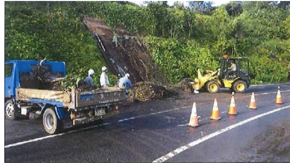
三本木スマートI方面入口土砂撤去(10/12深夜)
