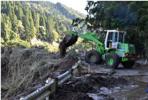
丸森町R349道路啓開作業 (10/16)
