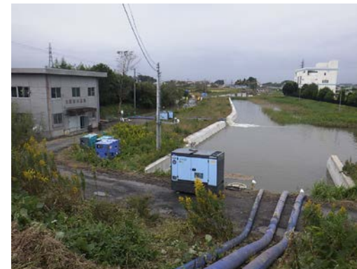
迫町揚水機場排水作業 (10/14)
