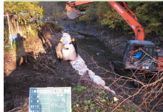
津山町北沢川仮復旧 (10/21)
