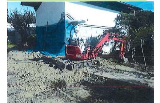
個人宅地内土砂撤去作業(10/17)
