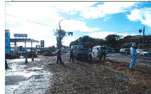
国道稲わら撤去作業
