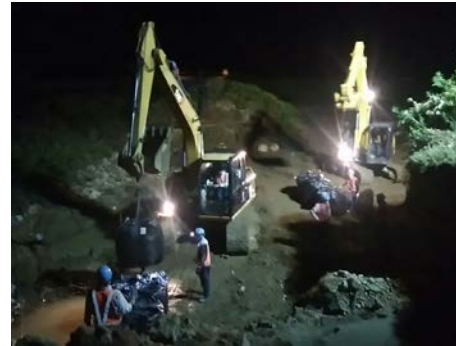
出来川堤防決壊緊急応急作業
