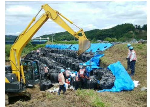
出来川堤防決壊緊急応急作業
