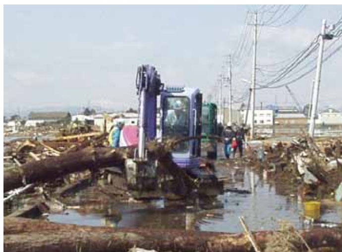
地域建設業が誰よりも早く被災地に駆け付け、各地を支援するための道路を使えるようにしました。
