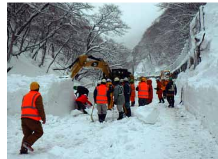
大雪で通行止めになった道路の除雪作業(仙台市青葉区作並地区)。冬に欠かせない除雪も建設業の重要な仕事です。
