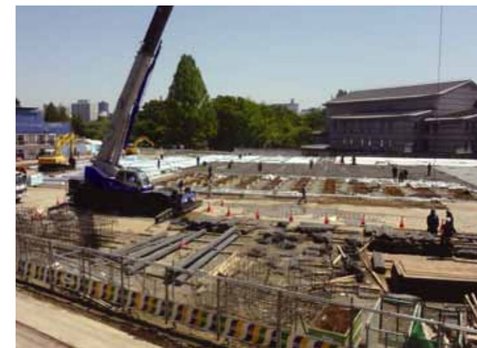
国連世界防災会議のメイン会場となる仙台国際センター展示棟建設工事の現場。
