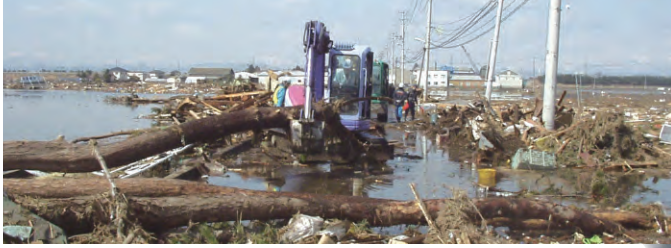
2011.3.12 仙台市若林区荒浜原町線道路啓開
