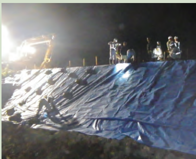
渋井川堤防復旧
