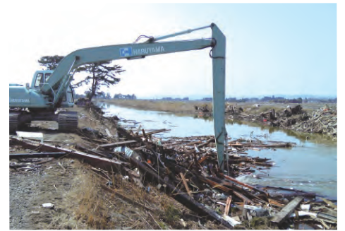
2011.3.29 貞山堀瓦礫撤去
