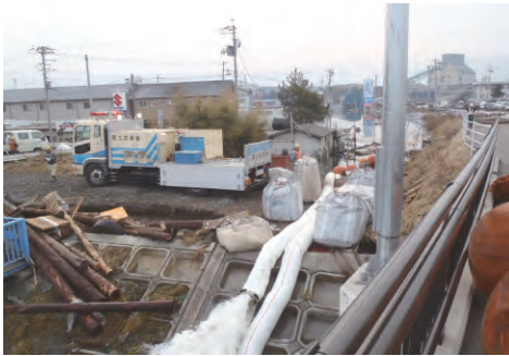
2011.3.13 東松島市大曲地区内水排水作業
