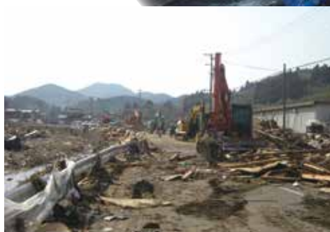
2011.3.13 南三陸町道路啓開
