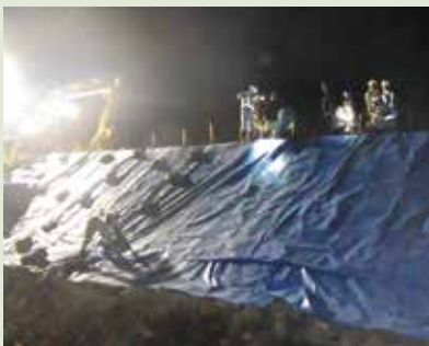
渋井川堤防復旧
