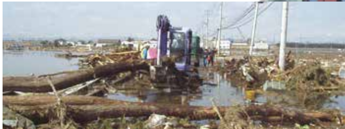
2011.3.12 仙台市若林区荒浜原町線道路啓開
