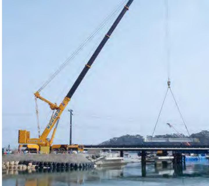
大型油圧クレーンを採用した松ヶ島橋の撤去工事(2013年3月7日)。
