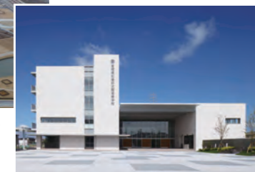
●石巻好文館高校舎改築工事
