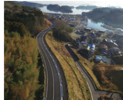
●利府町道須賀中倉線道路新設工事(2工区)
