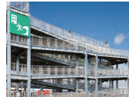
● (仮称) 仙台湾背後池3号公園津波避難施設整備事業新築工事 (仙台市津波避難施設第1号)
