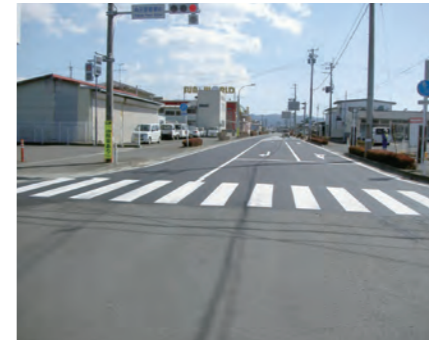
●角田外舗装補修工事
