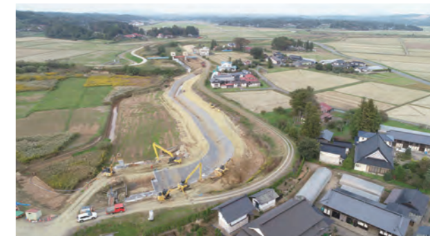
● 夏川築堤工事
