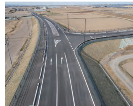
●宮城県舗装工事
