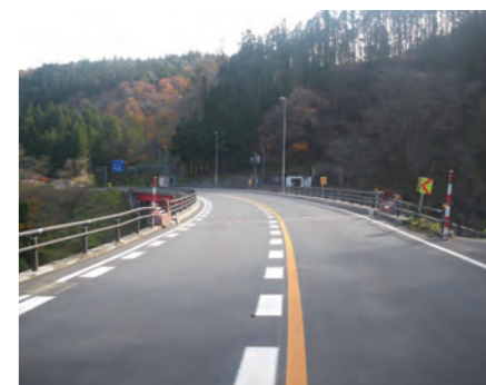
● 鳴子地区橋梁補修工事(施工場所:大崎市)
