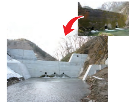
●草木沢砂防災害復旧工事 宮城県
