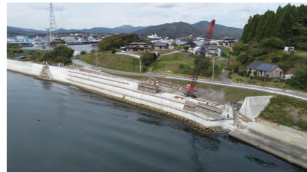
● 気仙沼漁港小々汐防潮堤災害復旧工事
