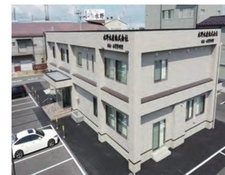
●水野水産(株)新社屋新築工事
