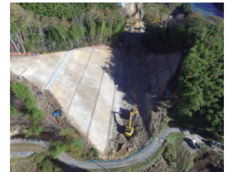
●土木工事施工
