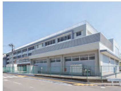
● 仙台市立大和小学校増改築工事
