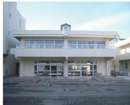
●一迫中学校大規模改造工事 栗原市
