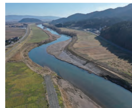
● 江合川下流猪岡短台地区河道掘削工事(施工場所:涌谷町)
