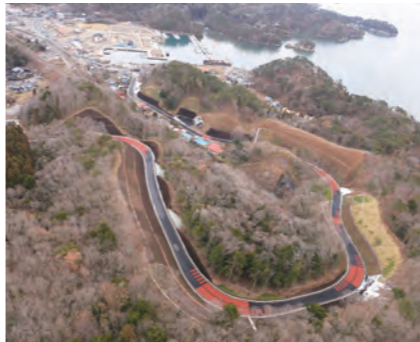
●利府町浜田地区避難路新設工事
