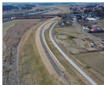
● 鳴瀬川三本木地区堤脚補強外工事(施工場所:大崎市)
