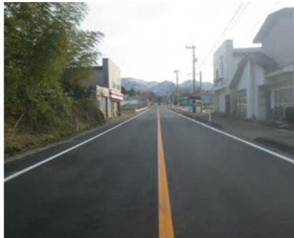
●小原外舗装補修工事
