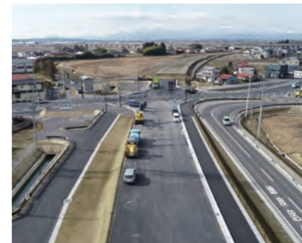
●古川大幡宮内地区道路改良工事
