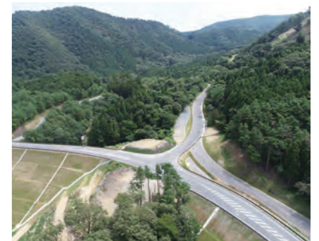
●小浜復興道路工事(その2)
