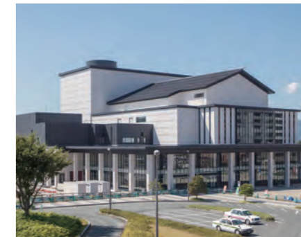
● 山形県総合文化芸術館（型枠工事）
