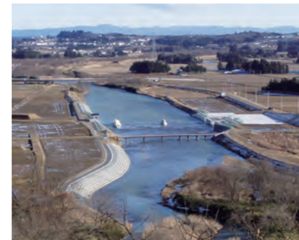
●秋山頭首工工事 宮城県
