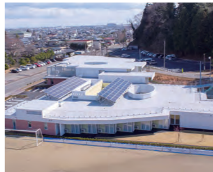
● 県南ありのまま舎（元請工事）
