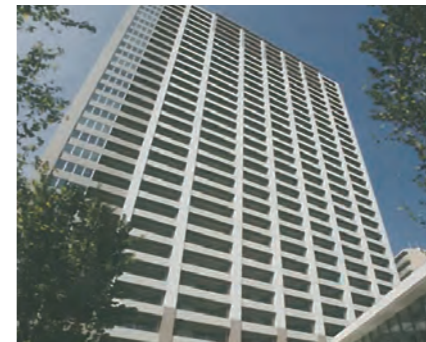
● ミッドプレイス仙台タワー&レジデンス（型枠工事）
