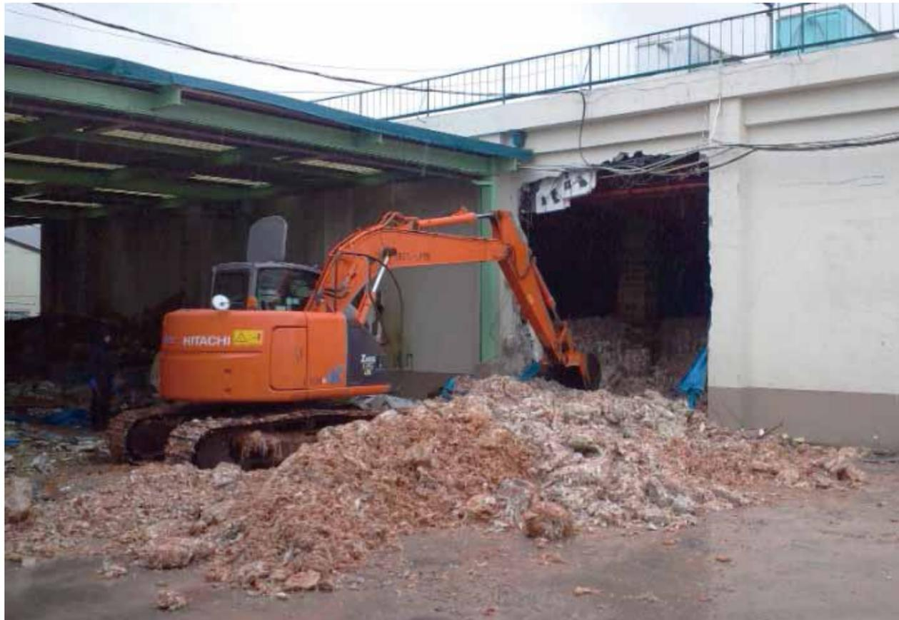
建機で冷凍庫を壊し(上)、水産物を取り出し(下)、手作業で分別した(右)
