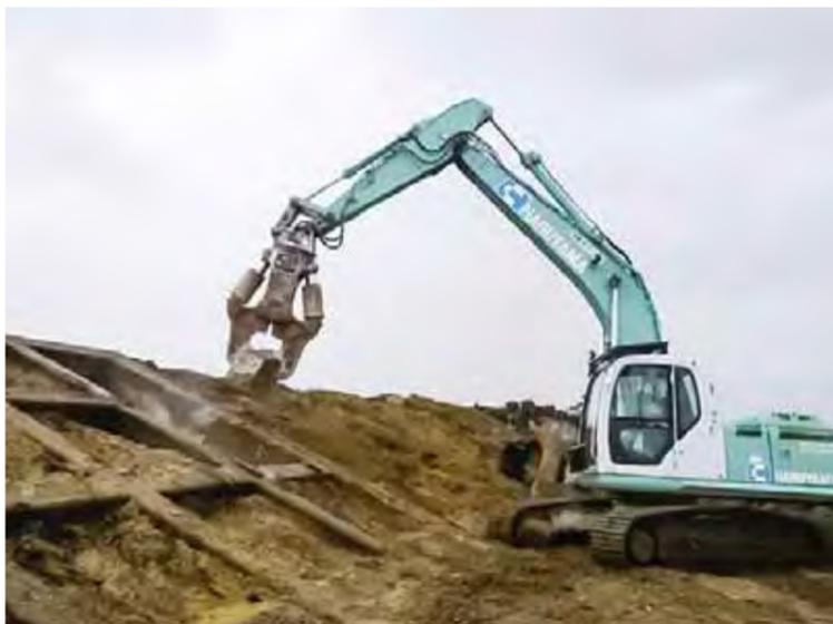
現場代理人兼監理技術者を務めている仙台湾南部海岸の堤防工事(2013年10月)。津波で壊滅的な被害を受けたため、取り壊して新たに堤防を復旧する。
