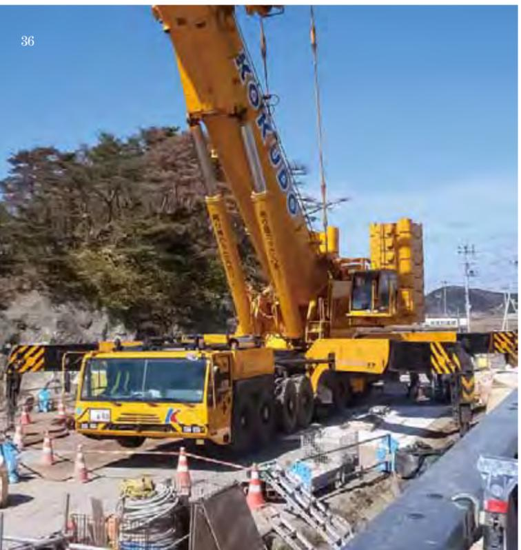
「橋の撤去も急ぎたい」ということだったので、日本に3台しかない650トン吊りの油圧クレーンを持ってきて、橋桁を一気に陸に吊り上げることにした(2013年3月)。
