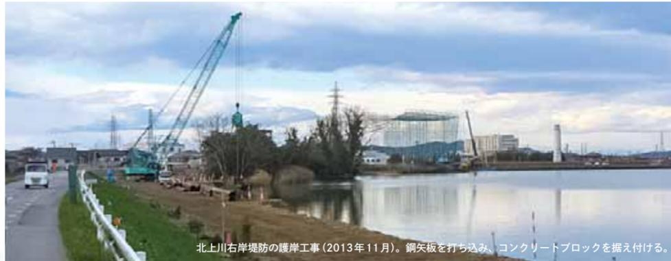
北上川右岸堤防の護岸工事(2013年11月)。鋼矢板を打ち込み、コンクリートブロックを据え付ける。
