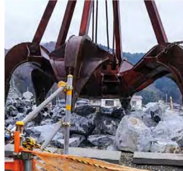
河川堤防の復旧工事での捨て石投入作業(2013年11月)。
