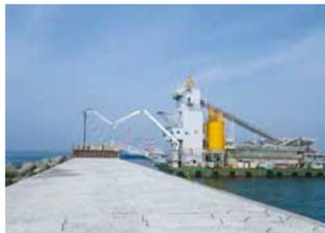
コンクリートミキサー船による仙台港の防波堤復旧工事。
