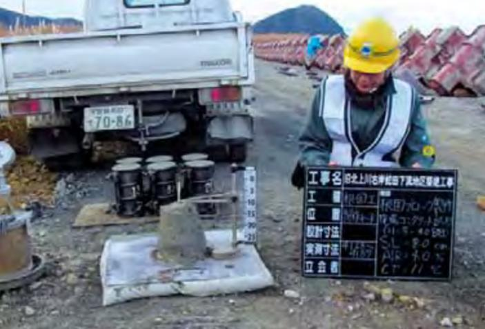
コンクリートブロック製作を担当。コンクリートの品質を確認している(2013年12月)。
