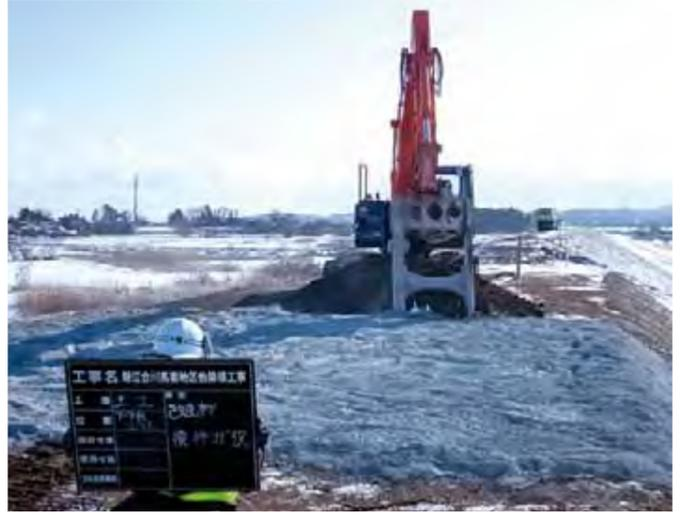
新江合川での復旧工事 (2012年1月)。クラックの最深部まで堤防の土を除去し、セメントで土を改良して盛土を行った。
