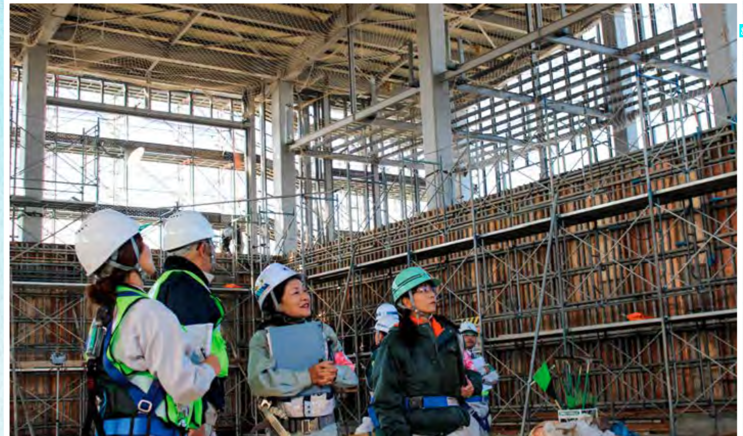
工事概要を聞いた後、女性目線で安全管理体制をチェックした。
