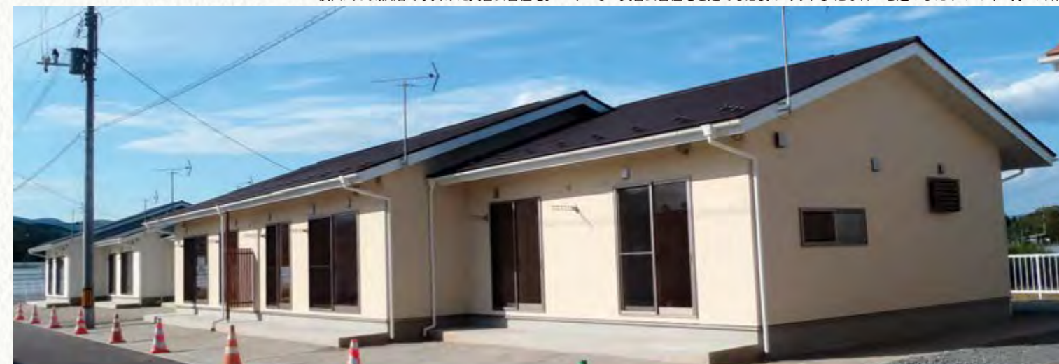
横田氏が気仙沼で手掛けた災害公営住宅。いくつもの災害公営住宅を建てる必要があり、多忙な日々を過ごした(2015年9月28日)。
