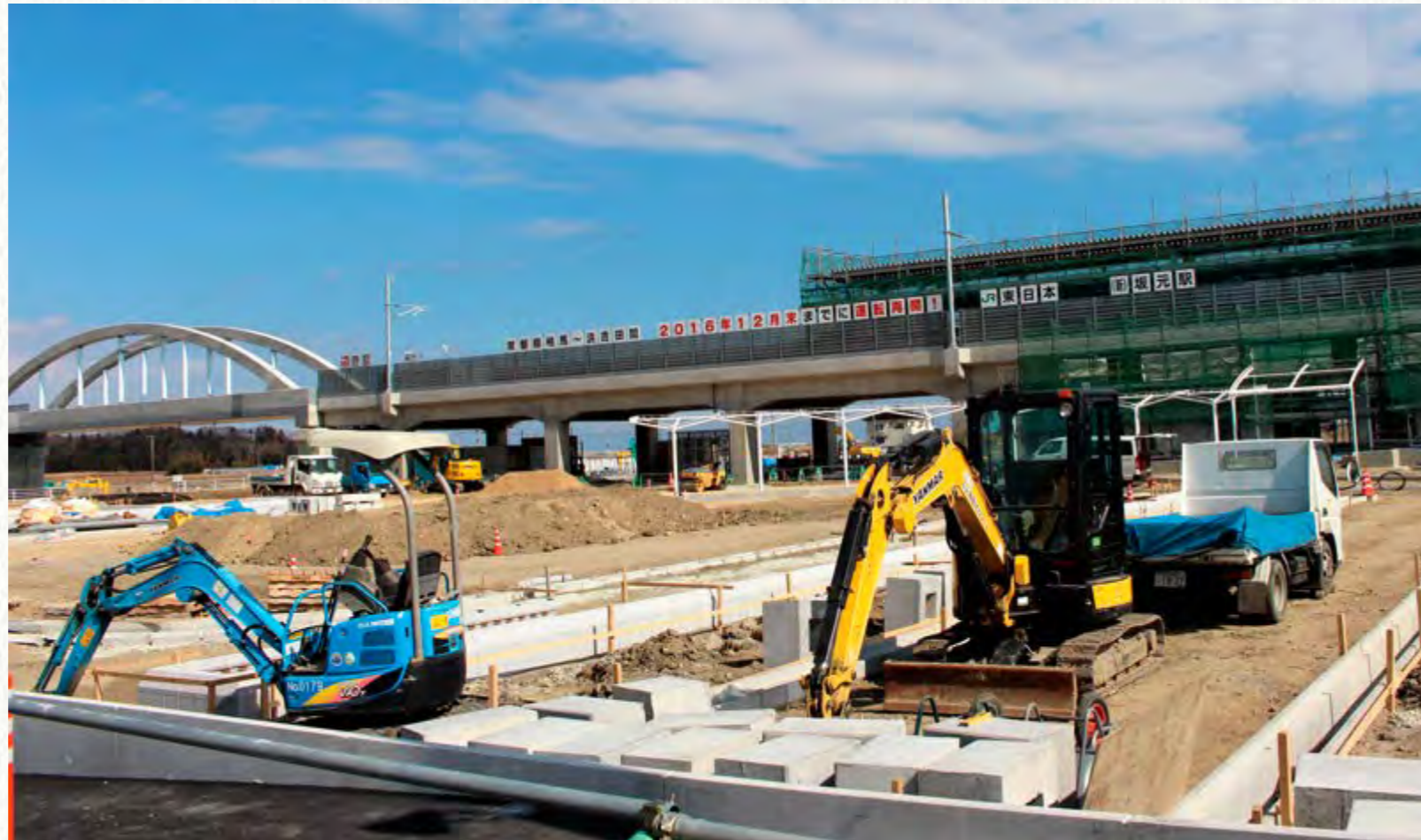
津波で壊滅し、常磐線の運転が2016年12月に再開されたJR坂元駅。内陸に移動して、まちづくりと一体で復旧工事が進められた（2016年2月28日）。
