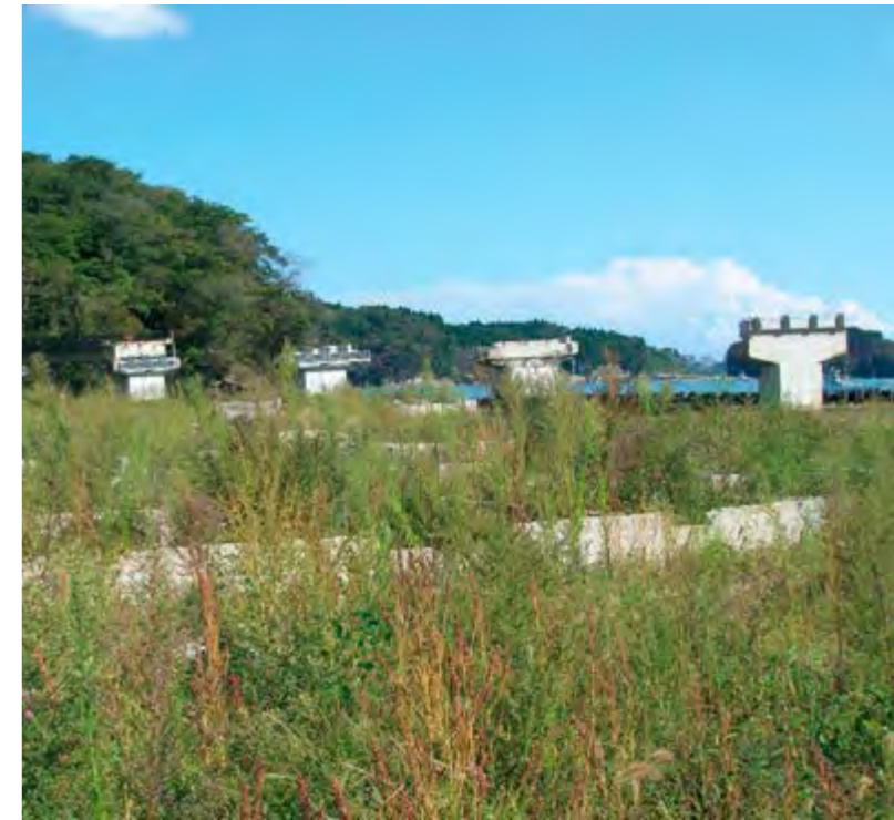
津波で壊滅し、荒地のようになってしまった伊里前地域(2012年10月5日)。
