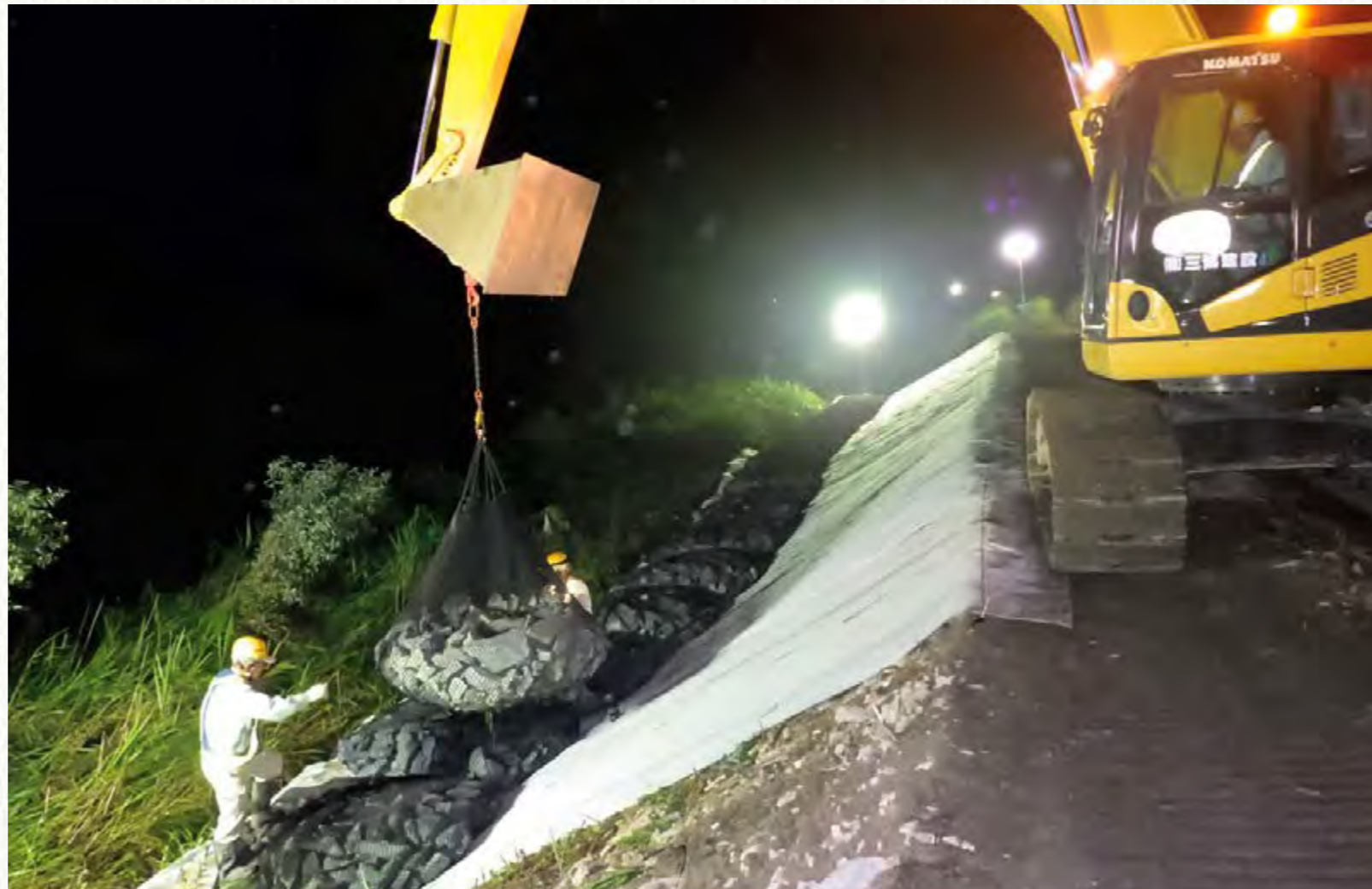
関東・東北豪雨災害が発生した際も、災害協定に基づき宮城県建設業協会の会員企業が出動した(2015年9月14日)。
