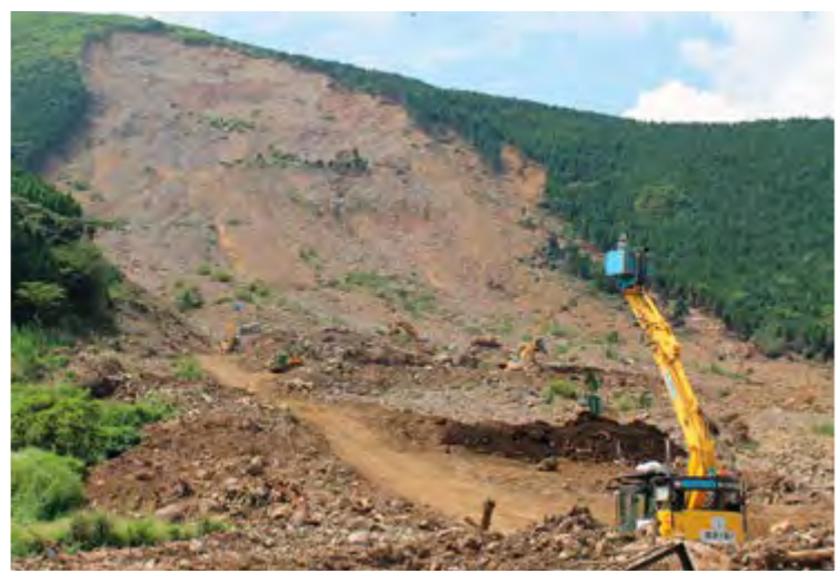
熊本県の阿蘇大橋地区では大規模な斜面崩壊が発生した。
