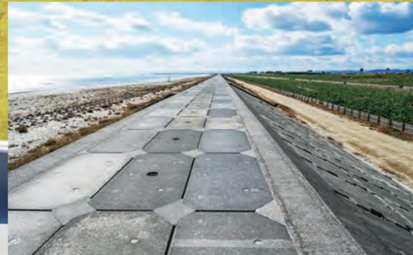
2019年11月30日に開通した東部復興道路「かさ上げ道路」(写真左)。海拔7メートルまでかさ上げし堤防機能を持たせ、海拔7.2メートルの海岸堤防(写真右)や海岸防災林などと合わせた「多重防御」により、津波被害の軽減に備える(2022年11月16日撮影)
