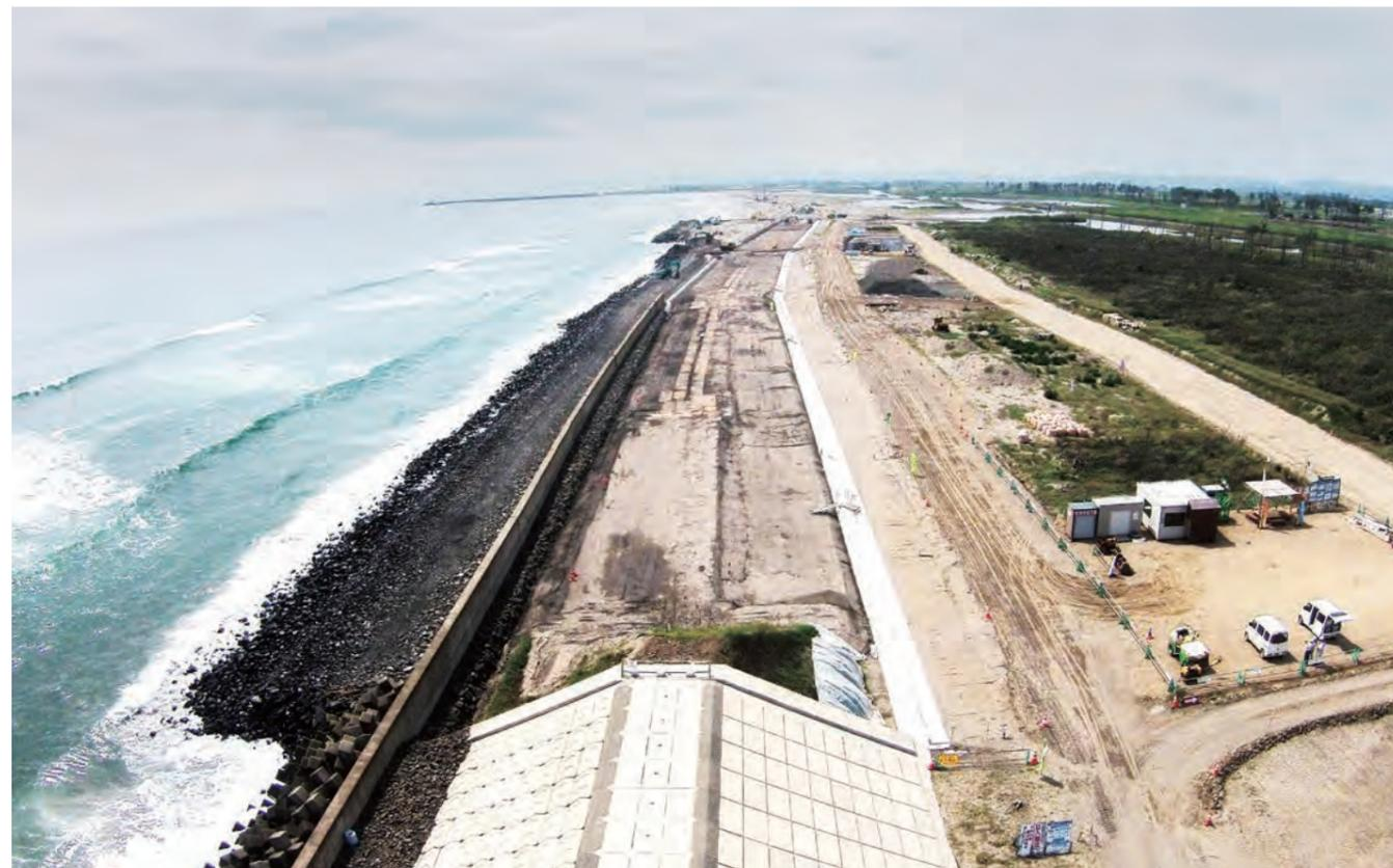
工事中の仙台湾南部海岸堤防の様子。海拔7.2mの堤防により、巨大津波発生時でも被害を軽減へ(2015年9月5日撮影)
