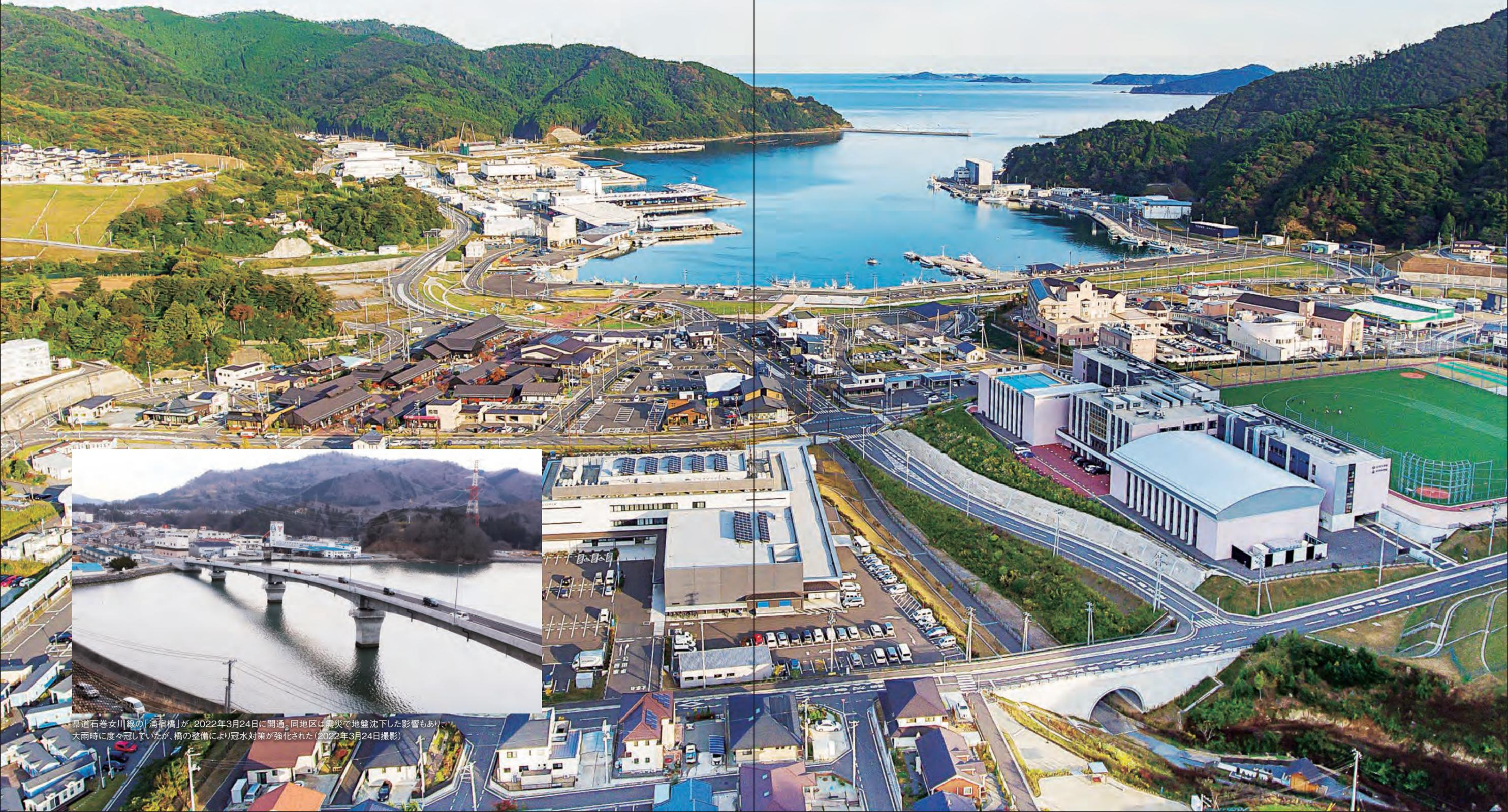
県道石巻女川線の「浦宿橋」が、2022年3月24日に開通。同地区は震災で地盤沈下した影響もあり、大雨時に度々冠っていたが、橋の整備により冠水対策が強化された(2022年3月24日撮影)
