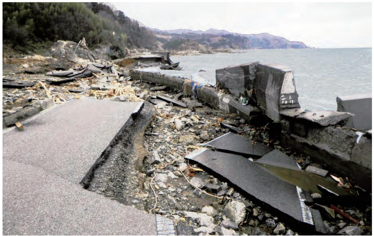
北上川河口部付近を通る国道398号は、津波で複数の箇所が寸断。その先には孤立した集落もあり、震災の3日後から道路啓開と緊急復旧工事が開始された
