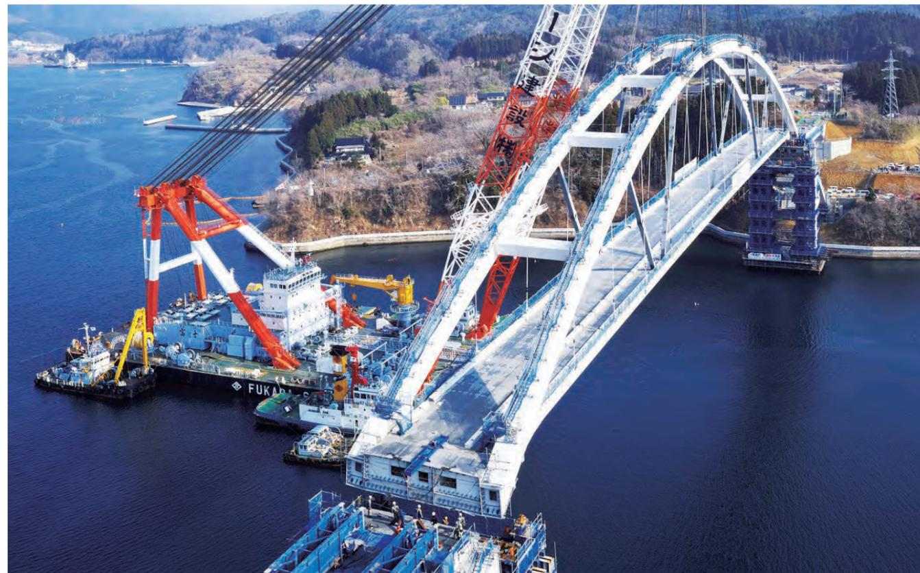
起重機船で運ばれた中央径間の接合作業。無事に架設工事が完了し、本土と大島がつながった(2017年3月29日撮影)
