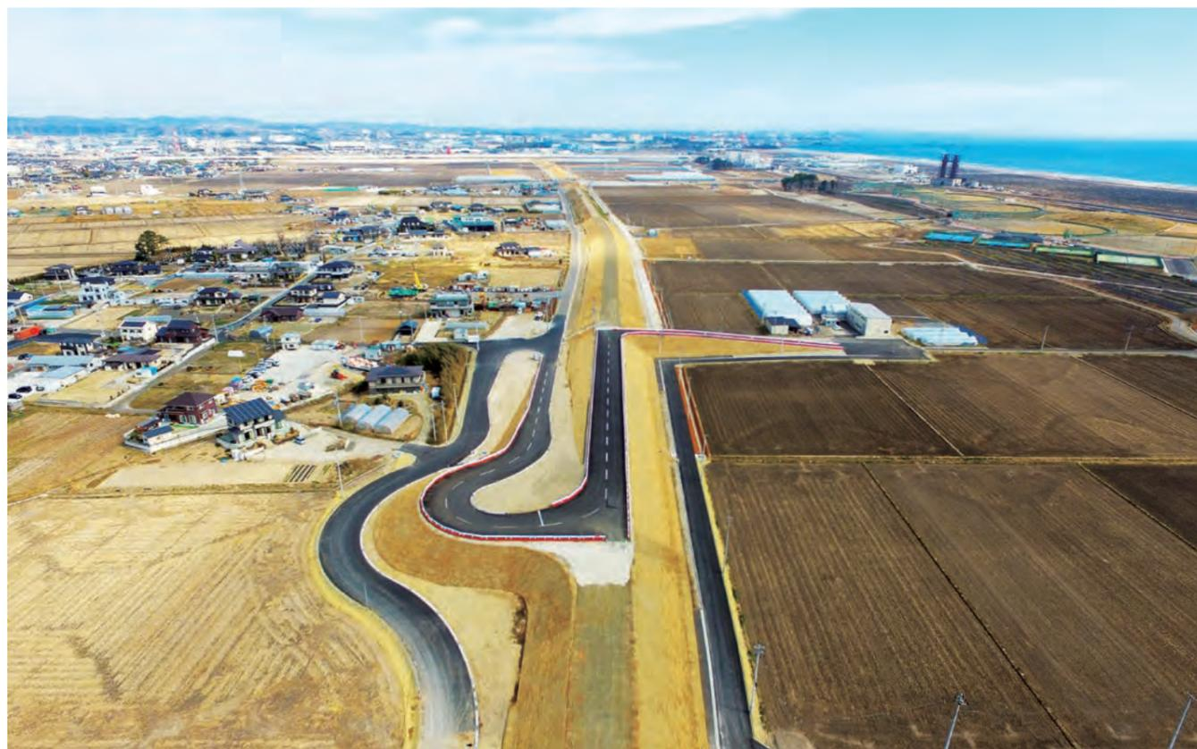
工事完成後の岡田新浜工区。地盤を強固にして盛土を行った。複雑な道路形状は、施工に苦労した箇所の一つ(2019年3月25日撮影)
