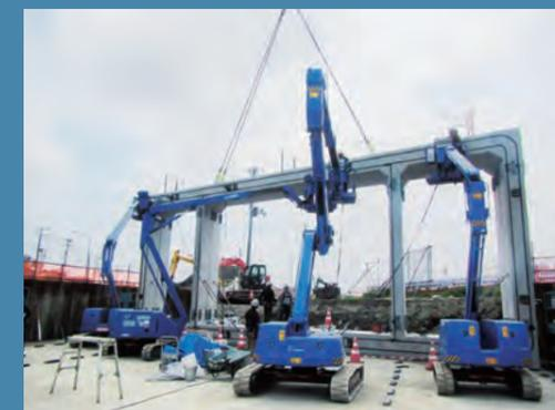
橋の取付道路工事、カルバート施工の様子(2019年9月7日撮影)
