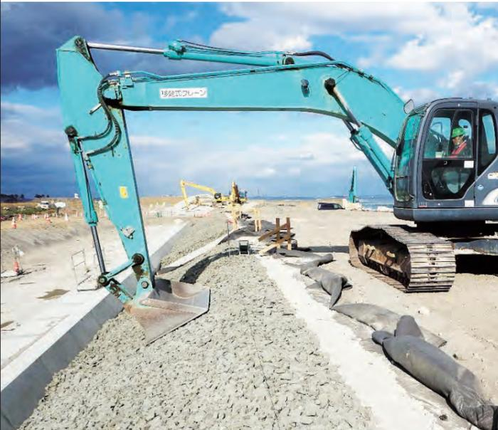
法面の補強、地盤改良などにより、「粘り強い」堤防に
